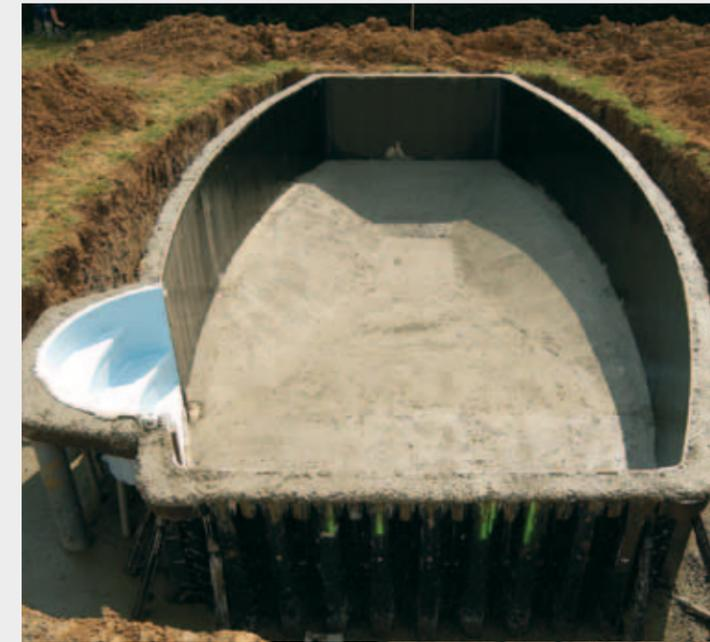
A moldagem com bomba de betão é efetuada numa única operação após a ferragem do fundo, das chaminés e dos rebordos superiores e inferiores, no caso de uma estrutura autoportante.
