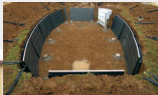
Colocação dos pinos e instalação das estruturas pré-montadas em fábrica.
